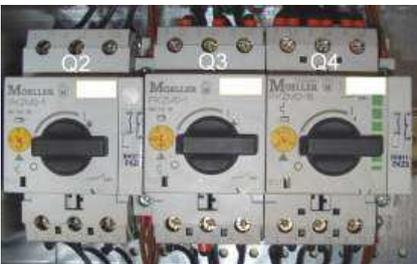
Abb. 1: Motorschutzschalter
